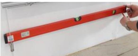
11. Utilisez un niveau à bulle pour déterminer le lieu d'installation du deuxième support d'angle. Les autres activités liées à l'assemblage du câble et du tendeur doivent être effectuées de la même manière que lors de l'assemblage.
