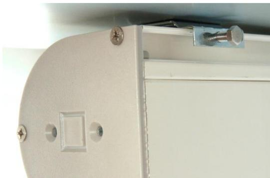
1. Mettre la cassette sur les clips installé et nivelé avant. Puis bloquer la cassette sur les clips en serrant la vis de blocage (utiliser une clé plat).
