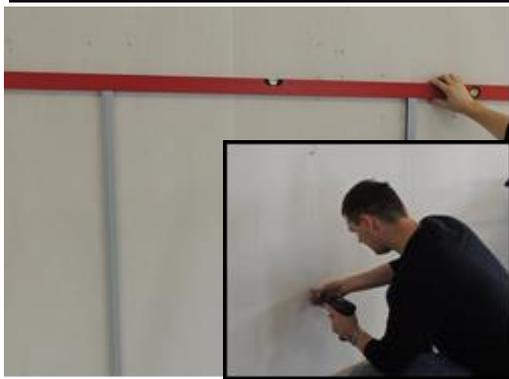
6. Vérifier le niveau supérieur des guides. Corriger si nécessaire
