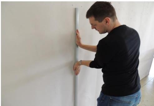
3. Installer les guides en imposant les sur des clips
