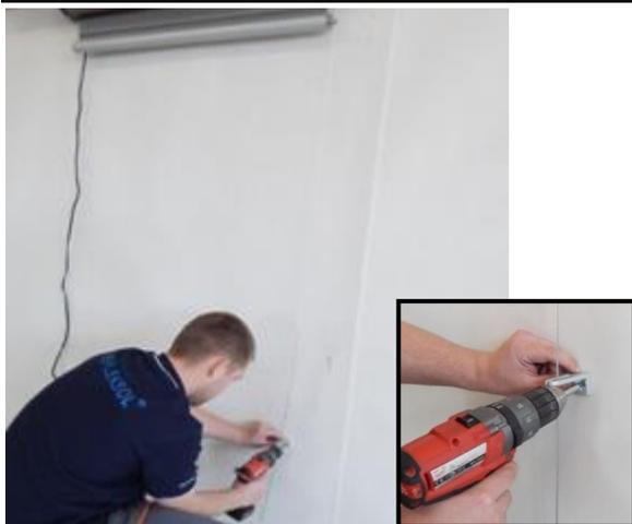
3. Déterminez le lieu d'installation puis vissez les supports de fixation des câbles
