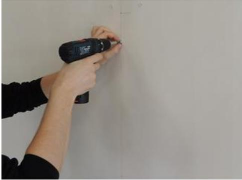
2. Visser les trous, et fixer le clips en acier, fixer le long de l'axe vertical, montage dans la partie fixe du guide.
