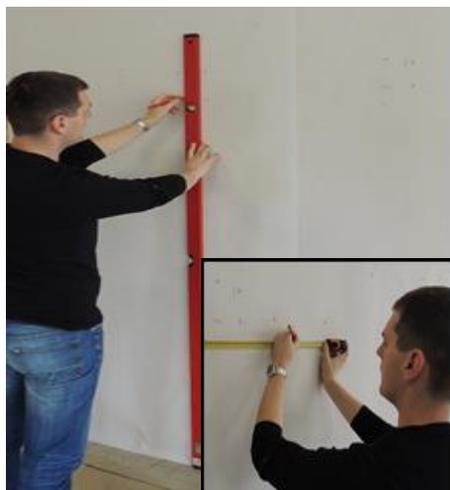
1. Mesurer et marquer les emplacements de fixation des supports de montage.
