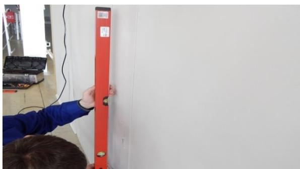
10. Utilisez un niveau à bulle pour vérifier la position verticale du câble. En cas de non-conformité, nous effectuons des ajustements en déplaçant le tendeur de câble dans le support d'angle
